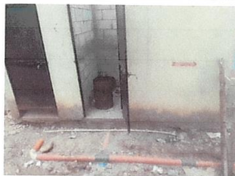
Foto 4: Instalando servicios sanitarios y lavamanos
