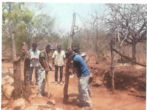
Foto 1: Trabajando en la instalación del porton
