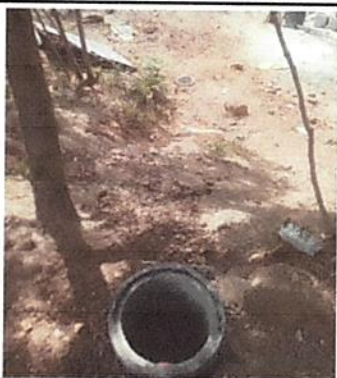
Foto 3: Instalacion de fosa septica
