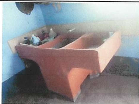
Foto 5: Instalación de pila
